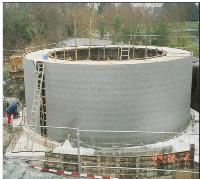
Das Regenüberlaufbecken ist ein Rundbehälter mit einem Durchmesser von 10 m und einem Fassungsvermögen von 250 m 3 . Bei der Erstellung der Behälterwände des Regenüberlaufbeckens kam eine Zem-Drain-Bahn zum Einsatz.
