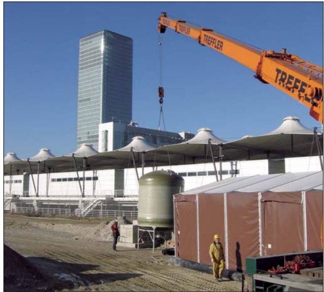
Einheben eines von insgesamt 26 GFK-Druckbehältern für Aktivkohle (Innendurchmesser 3 m), mit speziell für die 50-jährige Laufzeit entwickeltem V4A-Untergestell, in eines von vier Gates.
