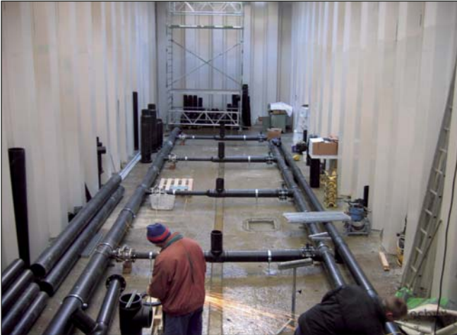
Die Rohrleitungen für Zulauf und Rückspülung wurden vor Ort in den bis zu 35 m langen Gates gefertigt, die als ausgesteifte Stahlspundwandkästen hergestellt sind.
