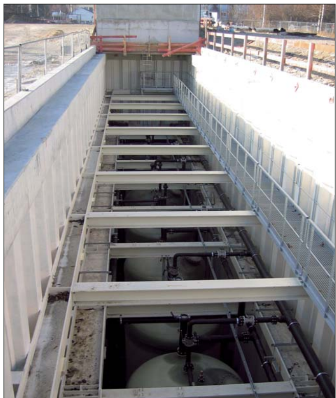
Am Gate 1 mit seinen acht eingebauten Filterbehältern befindet sich die Leitwarte für die gesamte Anlagentechnik, die alle Parameter der Gesamtanlage online aufzeichnet.
