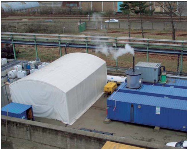
Bei einer Gesamtförder- und Reinigungsmenge von 5.577.000 m 3 entsprechend 85 m 3 /h wurden 41 % des gereinigten Wassers in das öffentliche Kanalnetz und 59 % in den Rhein abgeleitet
