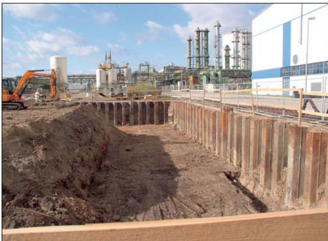
Um den Aushubbereich vor Grundwasserzutritt zu schützen, wurde dieser mit einem bis in 13 m Tiefe reichenden Spundwandkasten umschlossen.
