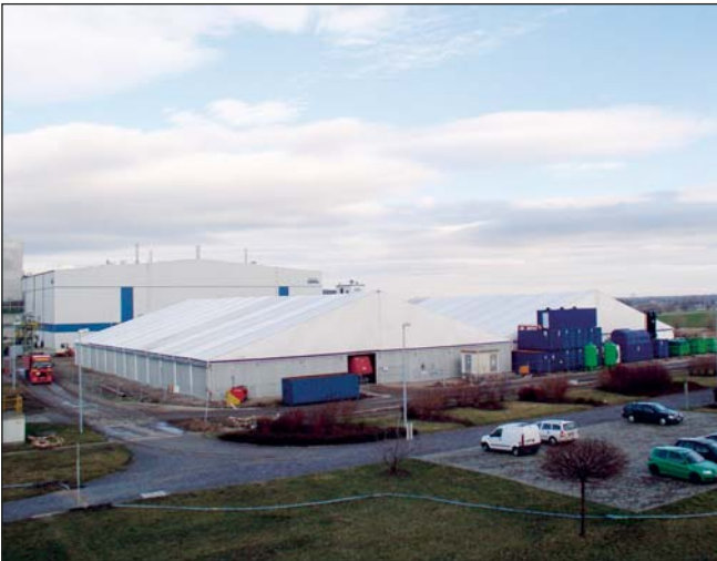
Die mit Baugrube und Bereitstellungslager rund 6.000 m 2 umfassende Baustelle wurde mit zwei freitragenden Zelten (90 m x 40 m und 60 m x 40 m) komplett umschlossen.
