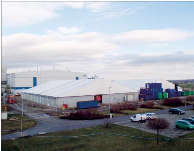
Die mit Baugrube und Bereitstellungslager rund 6.000 m 2 umfassende Baustelle wurde mit zwei freitragenden Zelten (90 m x 40 m und 60 m x 40 m) komplett umschlossen.
