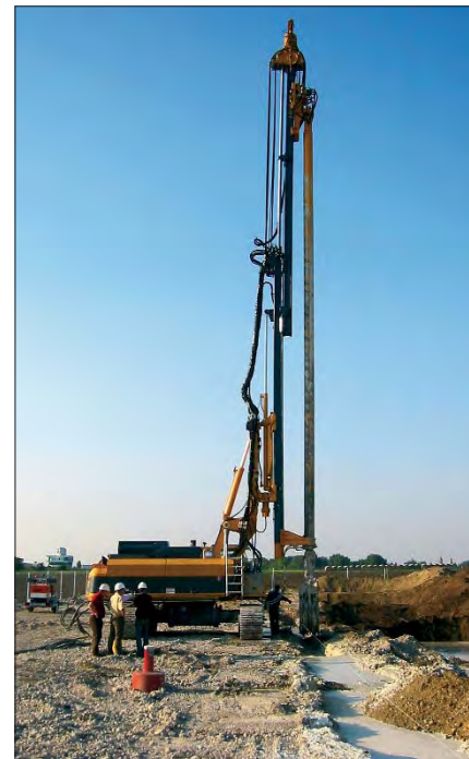
Die Dichtwand wurde im CSM-Verfahren mit Hilfe einer CSM-Fräse errichtet. Im Pilgerschrittverfahren wird der anstehende Baugrund gelockert und in situ mit der Dichtwandsuspension vermischt.
