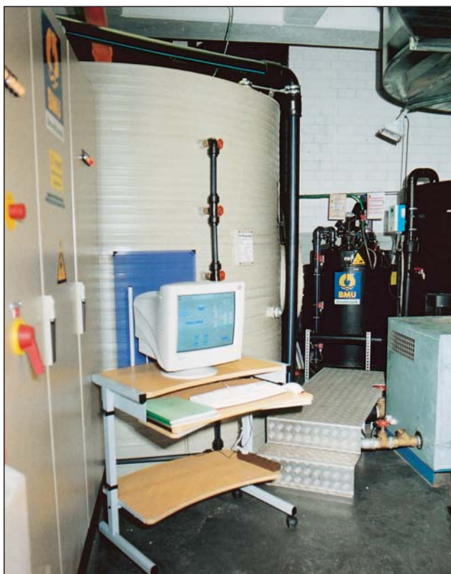
Steuerschrank, Prozessüberwachung, Rückspültank und Dosiercontainer
