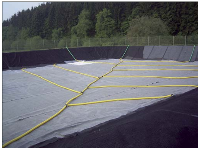
Unter der Drainage sind das Schutzvlies und die PE-Folie als Basisabdichtung eingebaut. Die Drainagerohre werden anschließend in eine grobkörnige Lavaschicht eingebettet.
