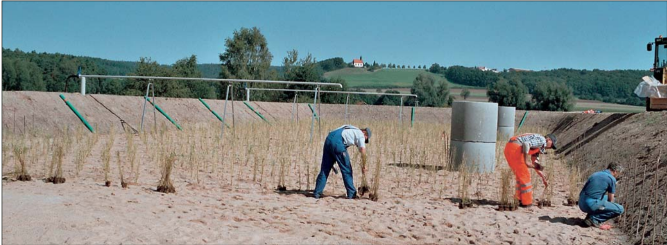
Einpflanzen der Schilfpflanzen im Vererdungsbeet. Im Hintergrund sind zwei aufgeständerte Beschickungsleitungen aus Edelstahl und zwei kontrollierbare Bodenabläufe System PURE zu sehen.
