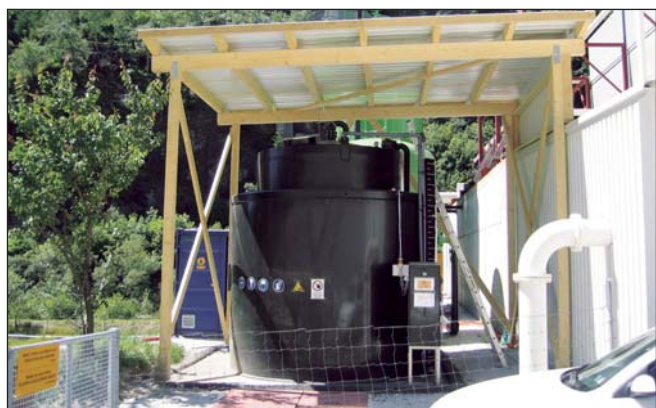
Der Vorratstank für Natriumhypochlorid zur Oxidation des Nitrats unterliegt besonders hohen Sicherheitsvorschriften, damit keine Gefährdung für Mensch und Umwelt entsteht.
