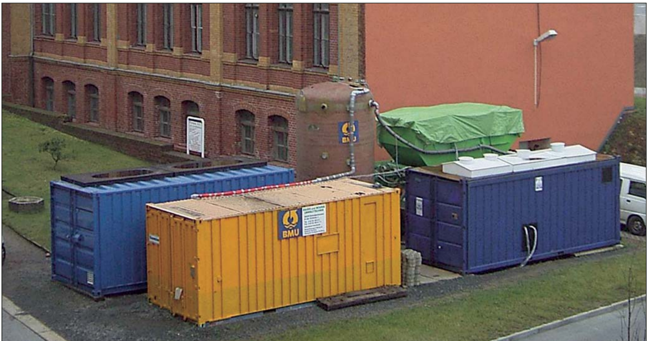
Die Anlage zur Reinigung von chrom- und LHKW-belastetem Grundwasser befindet sich inmitten des revitalisierten Industriestandortes. In den Containern sind die Komponenten für die einzelnen Verfahrensstufen untergebracht.
