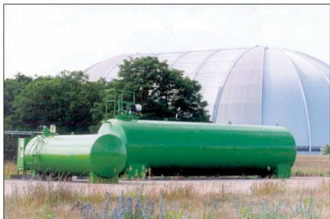
Ein 40 m 3 Kerosintank diente als Sammeltank für die wiedergewonnene Kerosinphase. Das Kerosin wird benutzt um Stromaggregate auf dem Standort zu betreiben.
