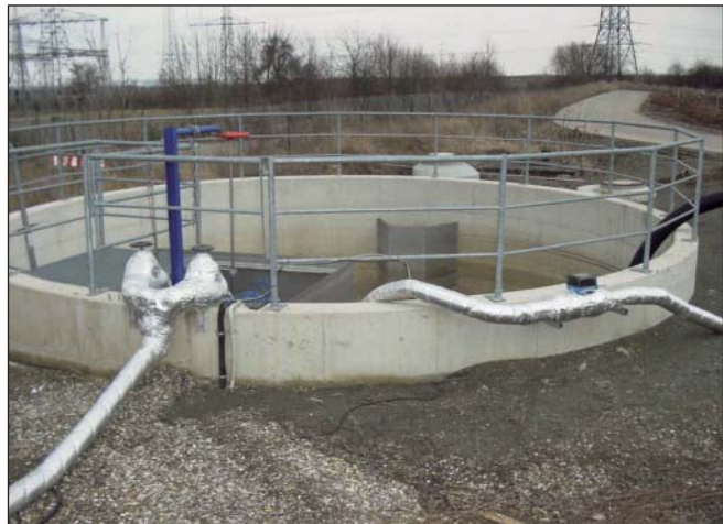
Neben der Grundwassersanierung ist auch ein Teilstrom von 4 m 3 /h aus Oberflächenwasser und Bauwasserhaltung zu reinigen. Als Rückhalte- und Absetzbecken für diese Wässer dient dieses Sammelbecken mit einem Fassungsvermögen von 70 m 3 .
