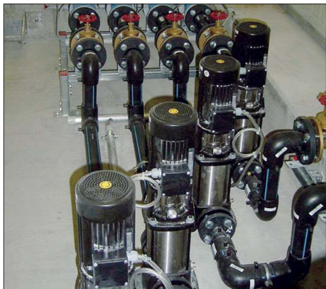
Die Fördermenge der vier Infiltrationsbrunnen, die über Pumpen einzeln beschickbar sind, wird über ein Durchflussmessgerät überwacht und die Wassermenge über einen Regler beeinflusst.
