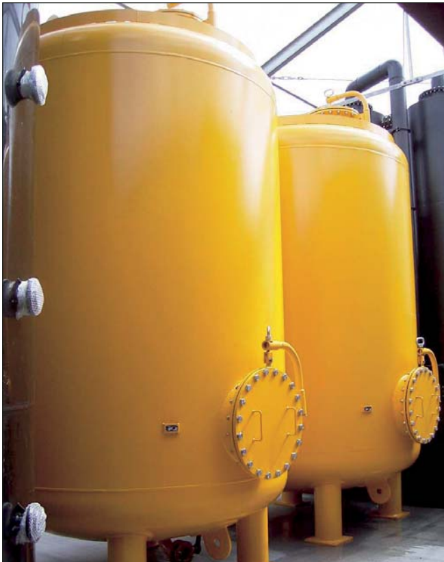
Die letzte Stufe der Wasseraufbereitung besteht aus zwei in Reihe geschalteten Wasseraktivkohlefiltern. Das Reinwasser wird anschließend infiltriert.
