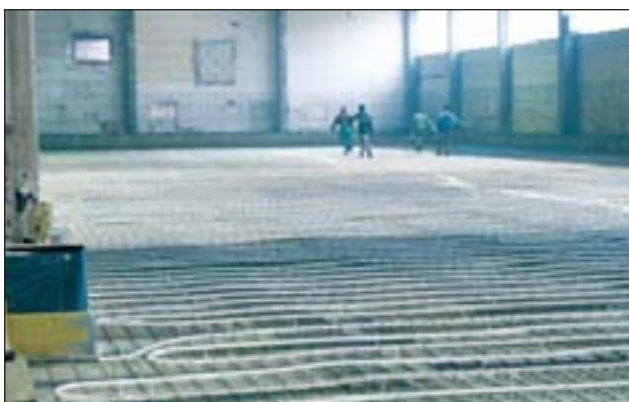
Installation und Aufbau der Fußbodenheizung
