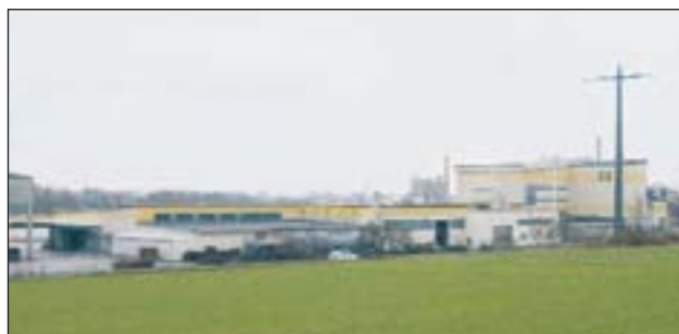
Gelände des Bodenreinigungszentrums
