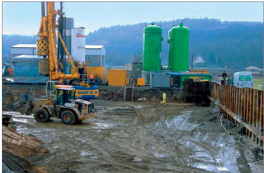
An der Schoberspitze wurden die Großlochbohrungen vom Niveau eines Voraushubs abgeteuft, der durch eine 500 m 2 große Spundwand gesichert wurde.
