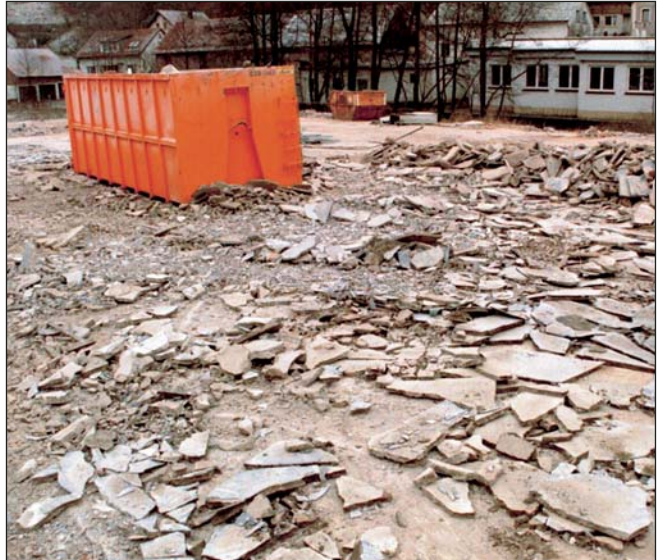
Der mit MKW belastete Estrich wurde entfernt und das Material anschließend auf eine Deponie gebracht.
