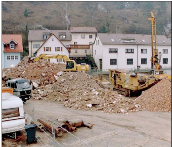
Die mineralische Bausubstanz wurde vor Ort gebrochen und nach einer analytischen Untersuchung und entsprechender Deklaration je nach Belastung entweder zum Wiedereinbau freigegeben oder auf eine Deponie gebracht.
