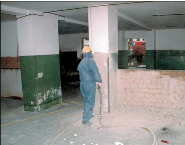
Die bestehenden Gebäude wurden vor dem Rückbau von belasteten bzw. gesundheitsschädigenden Baumaterialien entkernt. Insgesamt wurden 13.800 m 3 umbauter Raum rückgebaut.
