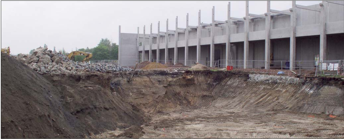
Im Sanierungsbereich 1 mussten 73.000 t kontaminierter Boden und 3.000 t kontaminierter Bauschutt ausgehoben und entsorgt werden.
