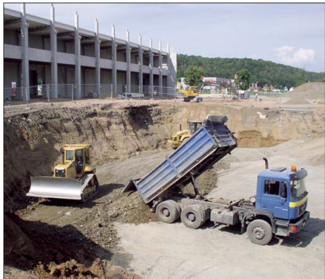
Die Wiederverfüllung der Baugruben erfolgte nach Erreichung des Sanierungszieles lagenweise mit insgesamt 112.000 t unkontaminiertem Material.
