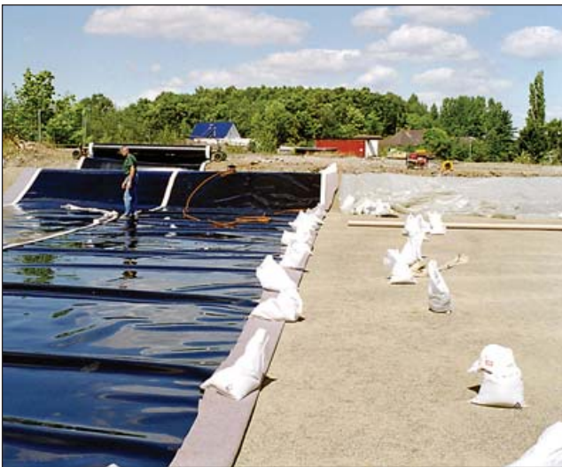
Errichtung der "Minideponie" mit Basisabdichtung auf dem ehemaligen Betriebsgelände, um den Restschlick gesichert abzulagern.
