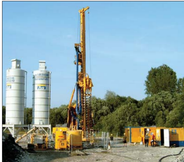
Gerätschaften zur Errichtung einer Dichtwand nach dem konzernintern patentierten Verfahren "Mixed-in-Place".
