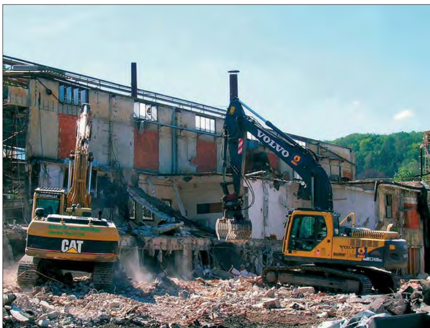
Zum Abbruch der 12 m hohen Hallen waren mehrere Bagger im Einsatz.
