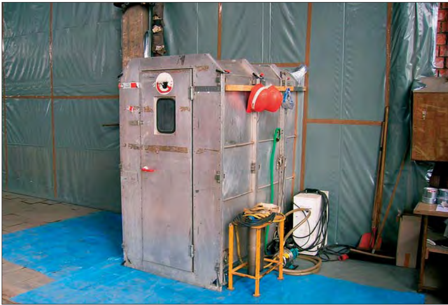
Die Asbestbelastung im Inneren der Gebäude machte besondere Arbeitsschutzmaßnahmen notwendig. Der Schwarzbereich wurde abgedichtet und konnte nur über eine Dreikammerschleuse betreten werden.
