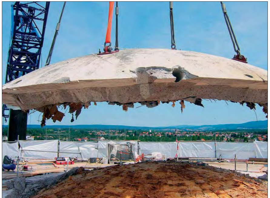
Das von der BAUER Umweltgruppe entwickelte Abbruchkonzept sah den segmentweisen Rückbau der Betonkuppel durch hydraulisches Pressen und Schneiden vor. Die bis zu 50 t schweren Segmente wurden mit Hilfe eines 500-Tonnen-Autokrans heruntergehoben.
