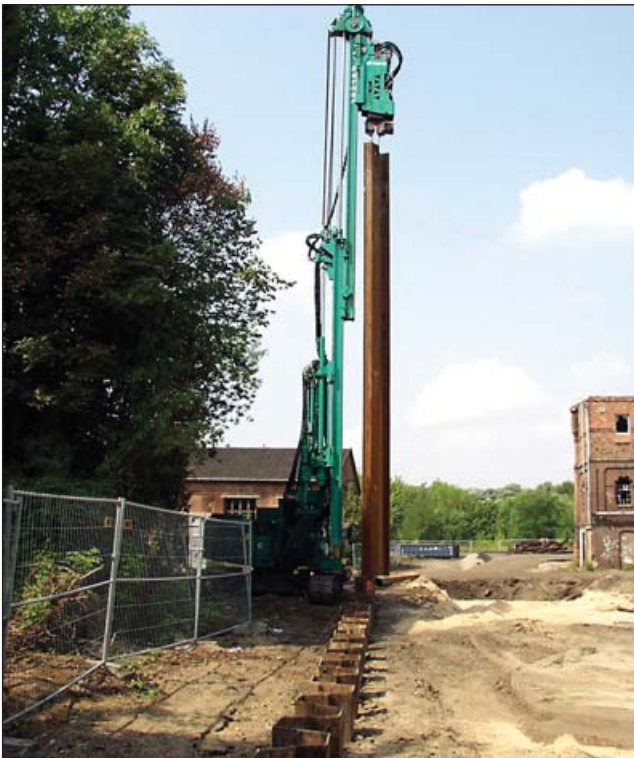
Eine 13 m tiefe Spundwand wurde in den Boden gerammt, um das Eindringen von Wasser in die Baugrube zu verhindern.
