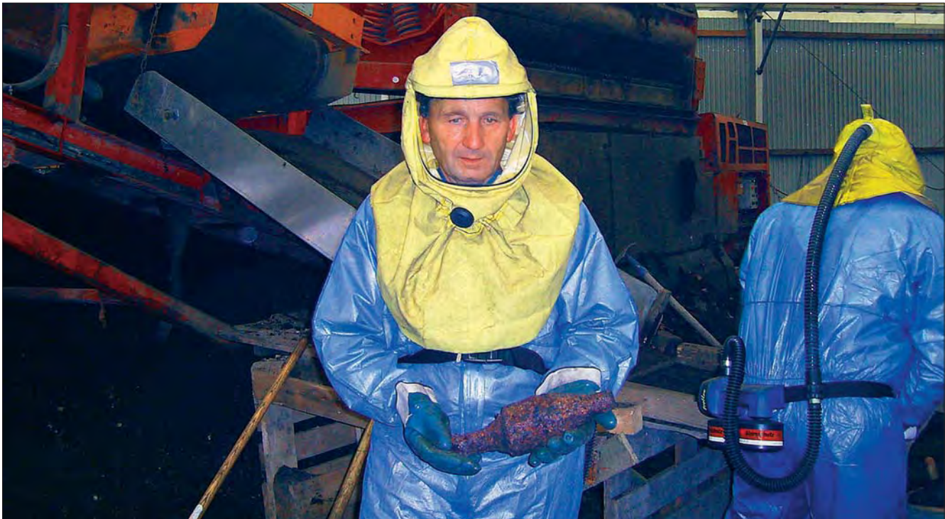
Die Munitionsbergung stellte hohe Anforderungen an die Arbeitssicherheit, da sich im Haldenmaterial auch explosive Sprengstoffreste und scharfe Munition befanden. Das Baupersonal trug Schutzanzüge und der Radlader wurde mit einem Splitterschutz ausgerüstet.
