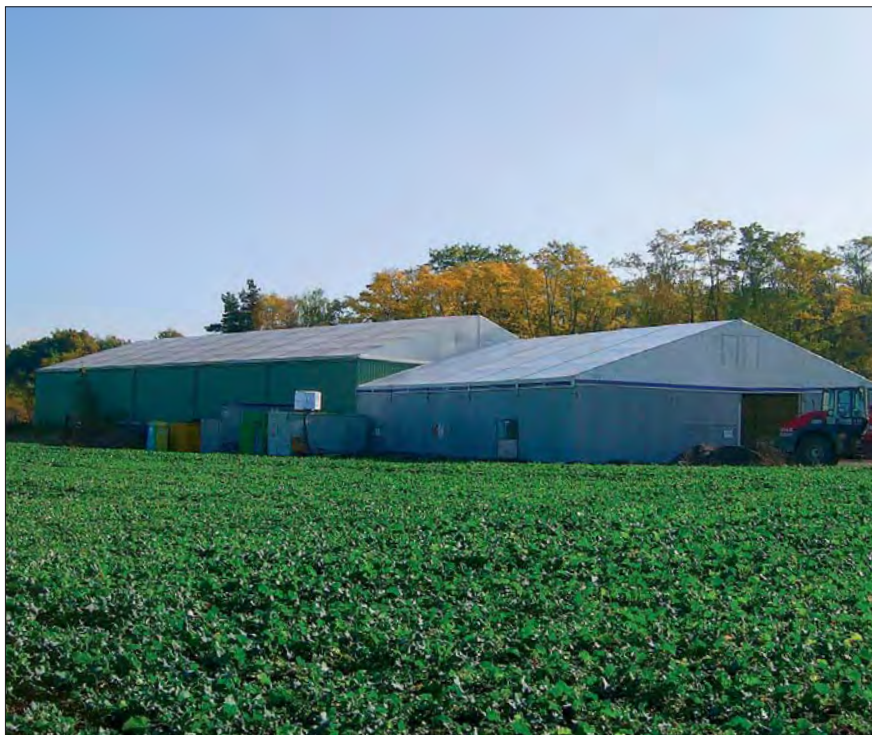
Vor Beginn der Sanierung wurde die Baustelle eingehaust und eine Abluftanlage installiert. So werden Emissionen von mit Sprengstoffverbindungen kontaminierten Stäuben in die Umgebung verhindert.
