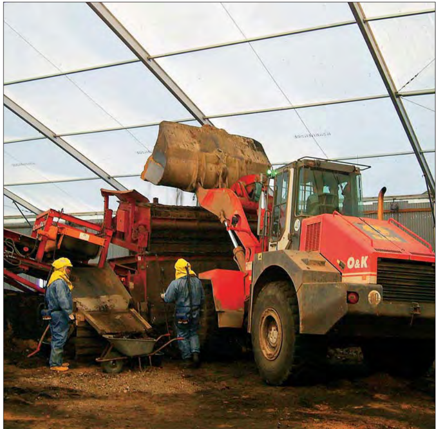
Das Haldenmaterial wurde gesiebt und mit Hilfe eines Magnetabscheiders von Munitionsresten befreit. Anschließend wurde der Boden im Bodenreinigungszentrum Hirschfeld der BAUER Umweltgruppe biologisch behandelt.
