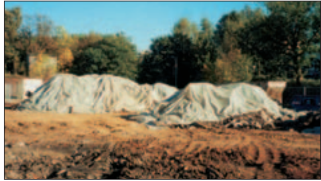
Abdeckung des kontaminierten Materials
