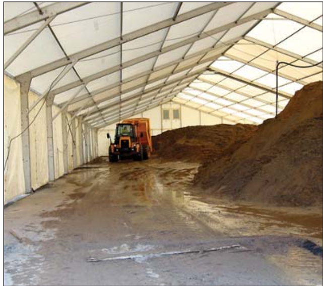
Um Emissionen aus dem geförderten Material in die Umgebung zu verhindern, wurde es bis zum Abtransport eingehaust gelagert.
