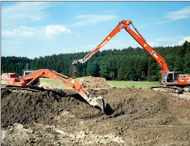
Nur mit einem Langarmbagger mit Filterkabine konnten die Deponiekammern ausgehoben werden.
