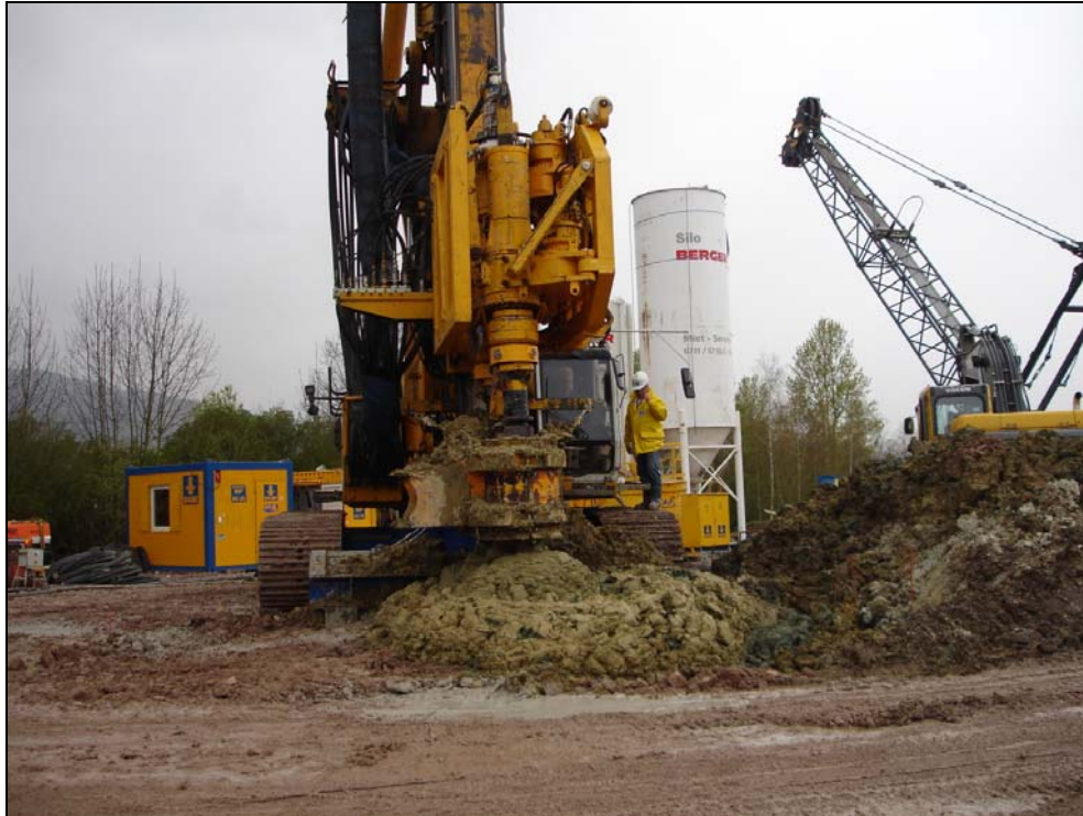
Bau der Drainagewand aus überschrittenen Kiesbohrpfählen
