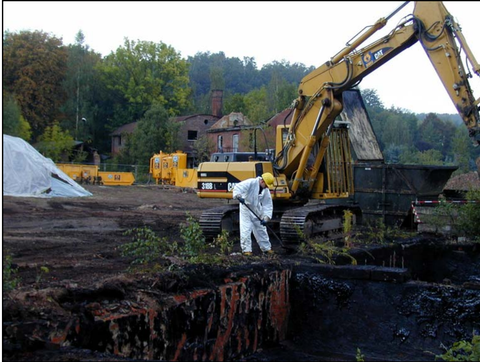
Beräumung der Teergrube in Sanierungsphase 2, im Hintergrund die Wasseraufbereitungsanlage
