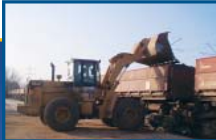
Für den Abtransport des Materials vom Gelände wurde eigens eine Trasse gelegt. Pro Zug wurden 1.000 t geladen, was fast 40 LKW-Ladungen entspricht.
