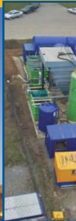
Das Bauwasser wurde mit Fällung und Flockung behandelt. Anschließend erfolgte eine Sedimentation über einen Schrägklärer. Ein Aktivkohlefilter war nachgeschaltet.
