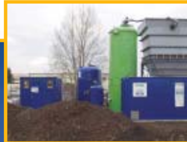
Das Bauwasser wurde mit Fällung und Flockung behandelt. Anschließend erfolgte eine Sedimentation über einen Schrägklärer. Ein Aktivkohlefilter war nachgeschaltet.
