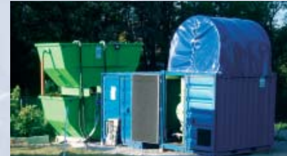
Die in Containern installierte Bodenluft-Absauganlage besteht aus einem Wasserabscheider und Aktivkohlefiltern.
