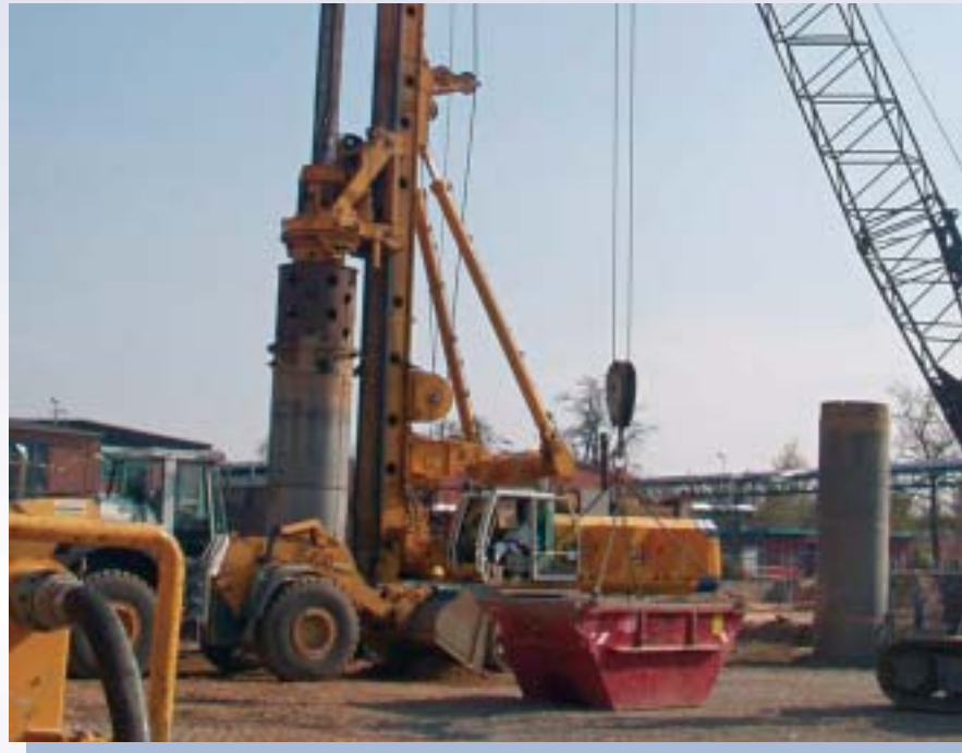
Mit überschnittenen Großlochbohrungen wurde der kontaminierte Boden in den exakt definierten Bereichen ausgetauscht.
