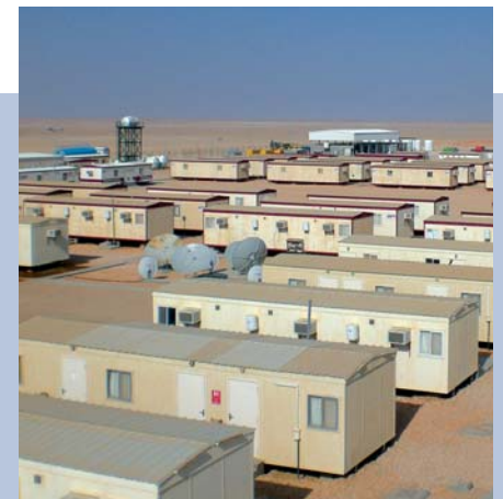
Das Baustellen-Camp beherbergt je nach Auslastung und Bauphase 150 bis 450 Arbeiter
