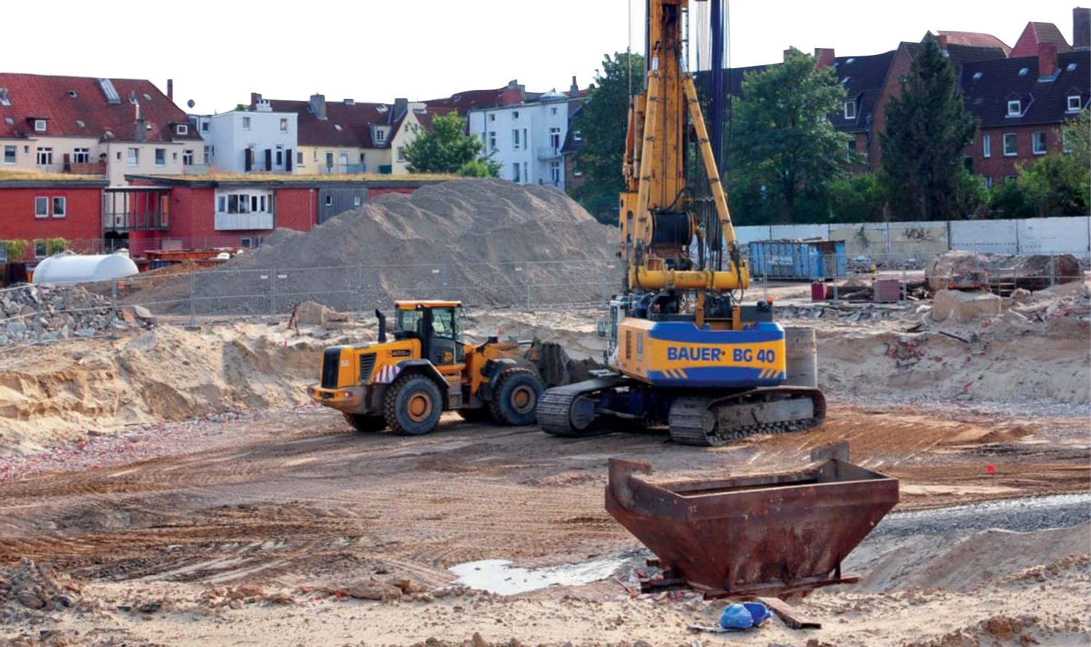
▼ Austauschbohrung mit einem leistungsfähigen Drehbohrgerät von Bauer Typ BG 40
