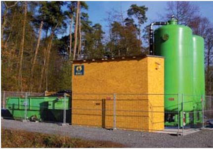
▲ Grundwassersanierung eines PFT-Schadens
