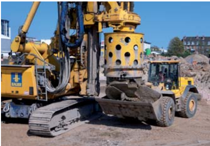
▲ Ausgehobenes Material wird sortiert
