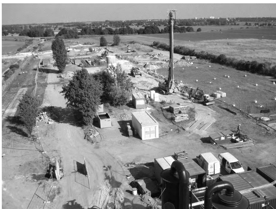
Bild 6: Blick auf die Baustelle während des Dichtwandbaus
