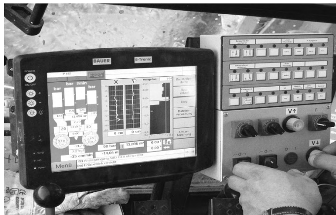
Bild 5: Überwachung der Herstellparameter beim Bau der Dichtwand
