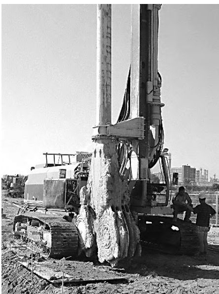
Bild 4: Mischwalzen beim CSM-Verfahren
