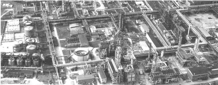
Bild 1: Alte Raffinerie Leuna vor dem Rückbau 1995/96
