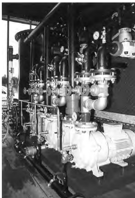
ATEX-konforme Wasserring-Vakuumpumpen zur Erzeugung des Unterdrucks
