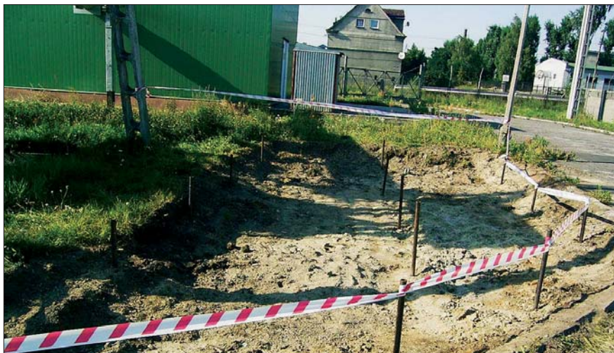
Der Einsatz eines Mini-Baggers zum Aushub des hoch belasteten Oberbodens erhöhte die Effizienz des Sanierungsverfahrens deutlich.
