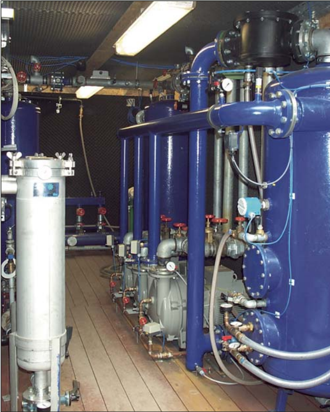
Mehrere Wasserringvakuumpumpen in verschiedenen Baugrößen ermöglichen eine genaue Anpassung an die geforderten Saugleistungen im hohen und niederen Vakuumbereich.
