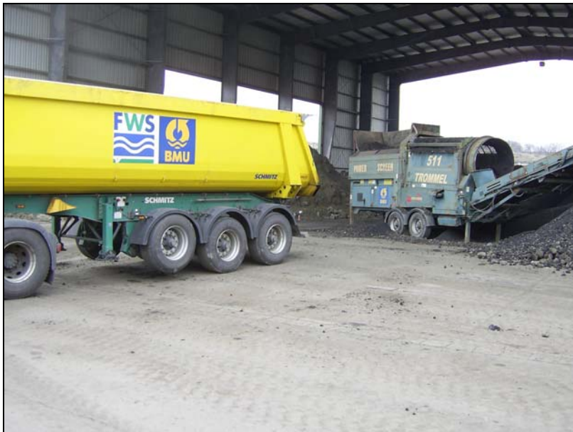
Bild: Annahmehalle mit mechanischer Vorbehandlung der Abfälle
