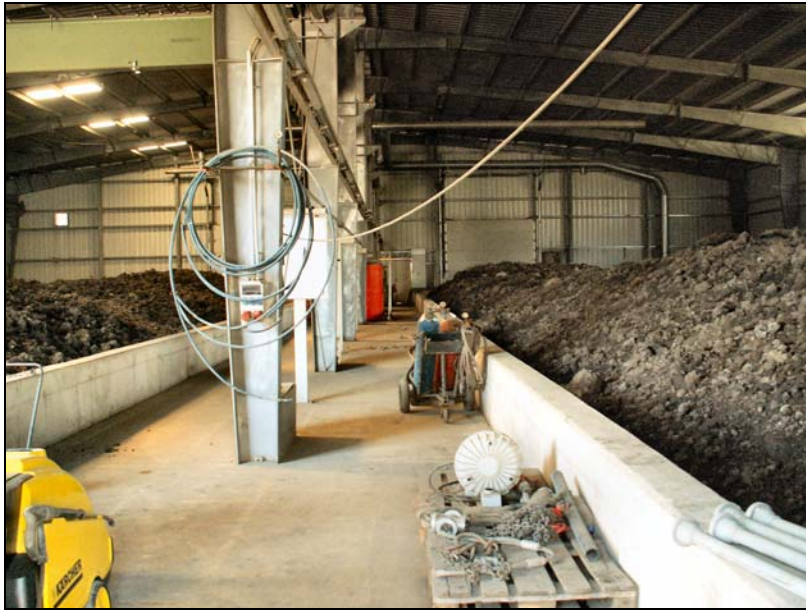
Bild: Behandlungsbecken zur Sanierung und Abreinigung der Kontaminationen
